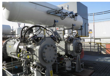
Neues Schmiersystem HydroCOM Aktuatoren auf dem Kompressor
