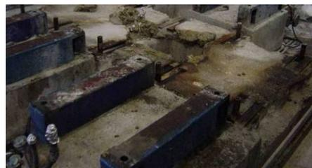
*Kompressor wurde vollständig vom Fundament abgebaut*
