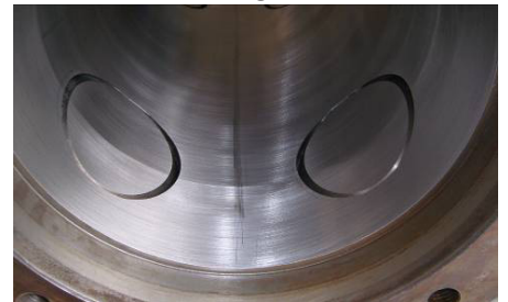
Neue Blindventile für reduzierten Verdichterschadraum clearance
